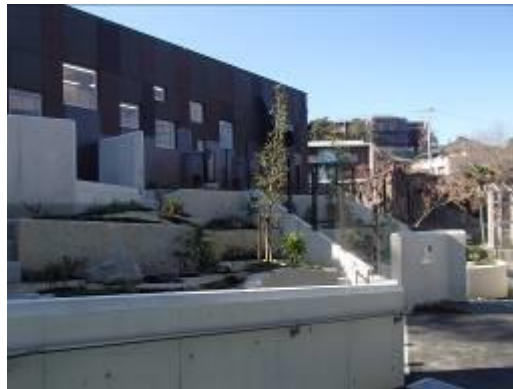
北運動場(12/7 撮影:工事中)
